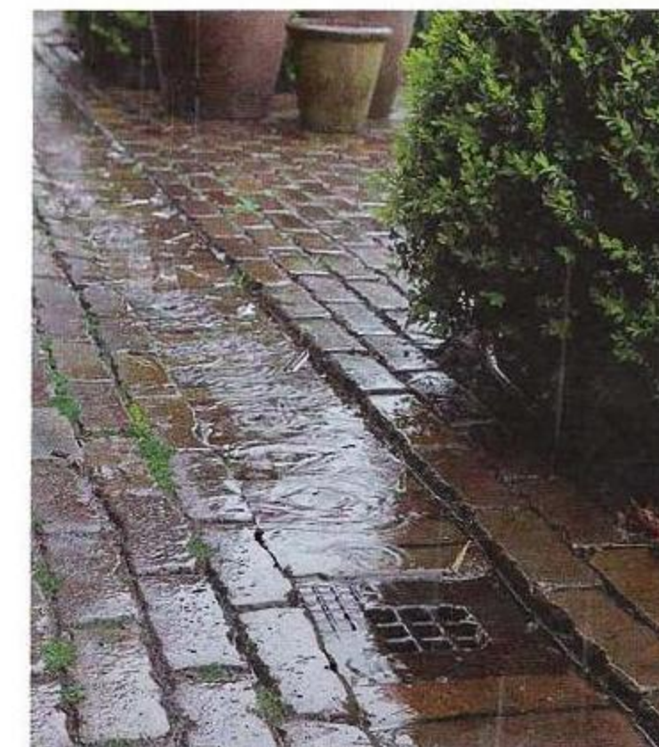
Regenwater dat direct van het dak op de terrassen stroomt, wordt door een in de bestrating verwerkte goot afgevoerd richting riool.
